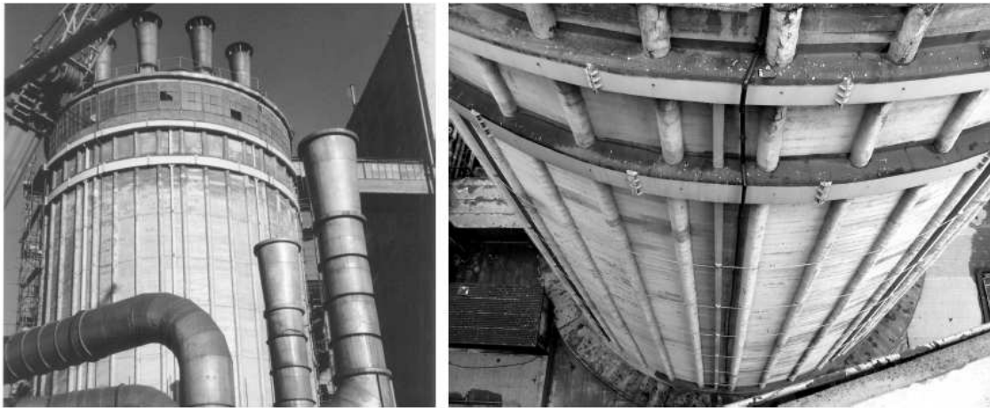
Rys. 7. Widok wykonanego wzmocnienia
