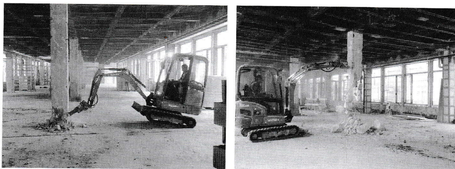
Rys. 11. Wyburzenie słupów
