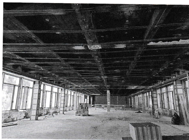
Rys. 12. Przestrzeń pod stropodachem po wyburzeniu słupów
