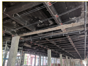
WZMOCNIENIE CIĘGNAMI ZEWNĘTRZNYMI
