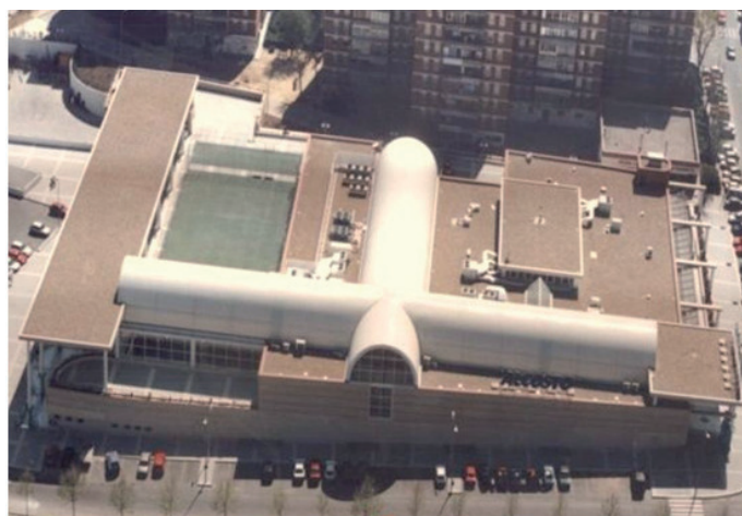
Rys. 10.5. Ogólny widok budynku centrum handlowego Fuenlabrada w Madrycie [41]
