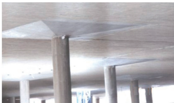
Rys. 10.6. Widok głowic słupów w budynku centrum handlowego Fuenlabrada w Madrycie [41]
