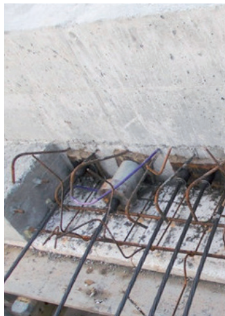
Rys. 12.11. Widok wgłębny przetwornika odkształceń (a) oraz siłomierza na cięgnię sprężającym (b) (fot. aut.)
