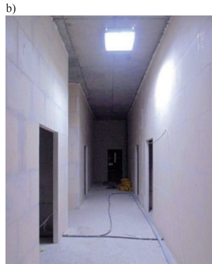
Rys. 12.20. Obciążenia stałe na płycie stropowej Pł-2: układ warstw i ścian działowych (a), widok ścian na stropie (b), (badania własne [142, 143])
