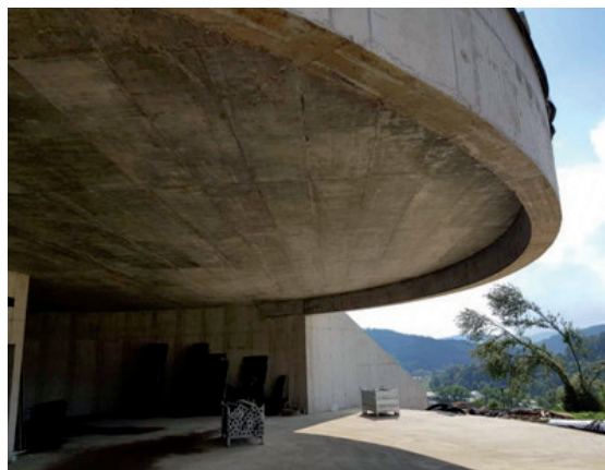
Rys. 13.14. Widok konstrukcji stropu po rozdeskowaniu (fot. aut.)
