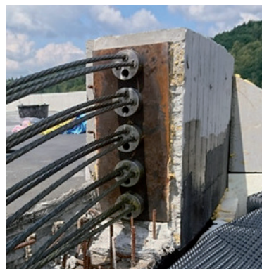
Rys. 13.13. Lokalizacja zakotwień cięgien sprężających z płyty w pobliżu belki oraz rozmieszczenie zakotwień w czole belki po jej zabetonowaniu (fot. aut.)
