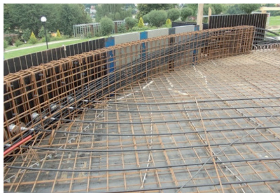
Rys. 13.13. Lokalizacja zakotwień cięgien sprężających z płyty w pobliżu belki oraz rozmieszczenie zakotwień w czole belki po jej zabetonowaniu (fot. aut.)
