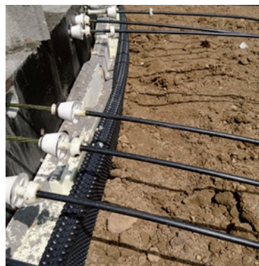
Rys. 13.12. Rozmieszczenie cięgien sprężających i zakotwień w płycie (fot. aut.)
