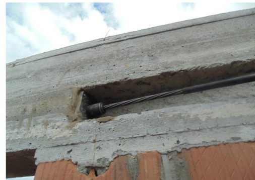
Rysunek 11: Widok wieńca sprężonego i wnęki kotwiącej
