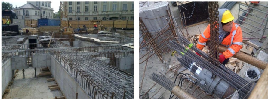
Rysunek 15: Widok belek zabetonowanych bez płyty (z lewej), sprężenie (z prawej)
