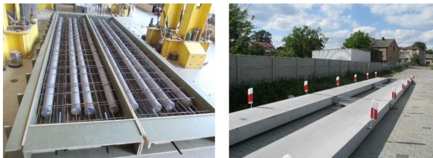
Rysunek 18: Płyta przygotowana do betonowania (z lewej), zrealizowany pomost w wersji wyniesionej (z prawej)
