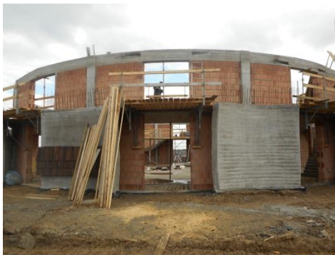
Rysunek 11: Widok wieńca sprężonego i wnęki kotwiącej
