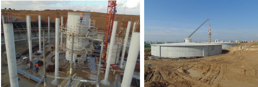
Rys. 59 Widok zbiorników w trakcie i po wykonaniu.
