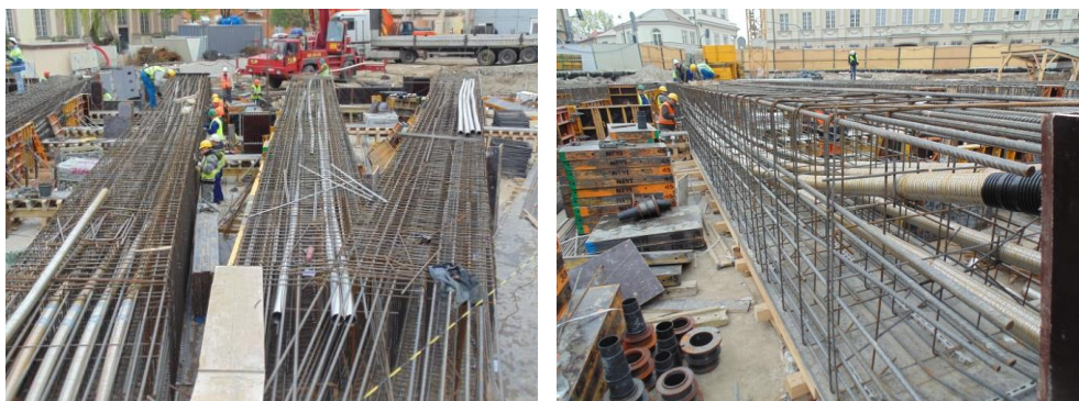
Rys. 52 Widok belek sprężonych w trakcie montażu zbrojenia i osłonek kablowych.
