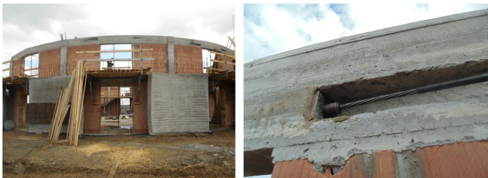
Rys. 62 Widok wieńca sprężonego i wnętrza kotwiącej.
