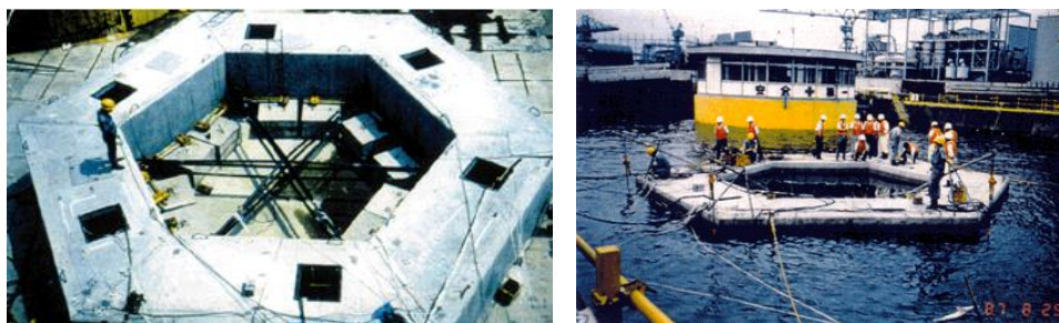
Rys. 74 Widok pływającej platformy betonowej podczas montażu i na wodzie.
