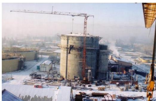
Rys. 57 Ukończona konstrukcja zbiornika ZKF w oczyszczalni ścieków w Żywcu.
