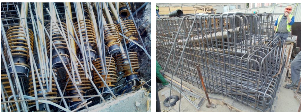
Rys. 53 Widok zakotwień biernych oraz zazbrojonego czoła jednej z belek sprężonych.
