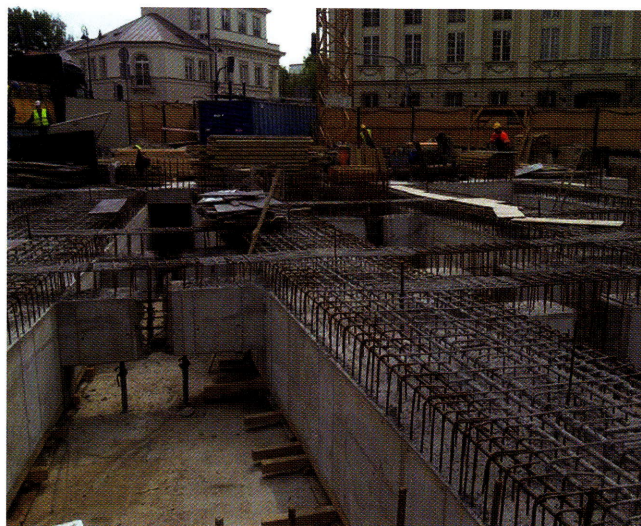
Rys. 4. Widok belek zabetonowanych do wysokości 1,2 m z przerwami poprzecznymi
