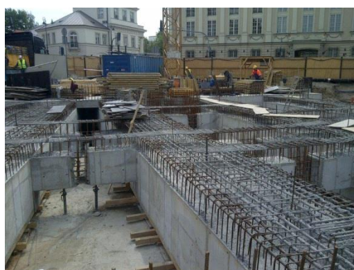
Rysunek 5. Widok belek zabetonowanych do wysokości 1,2 m z przerwanymi poprzecznicami.
