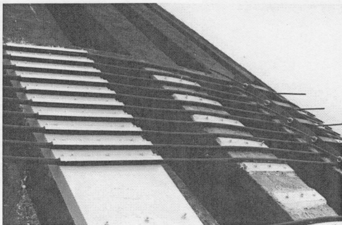
Ryc. 10. Widok cięgien przygotowanych do sprężenia powłoki stożkowej
