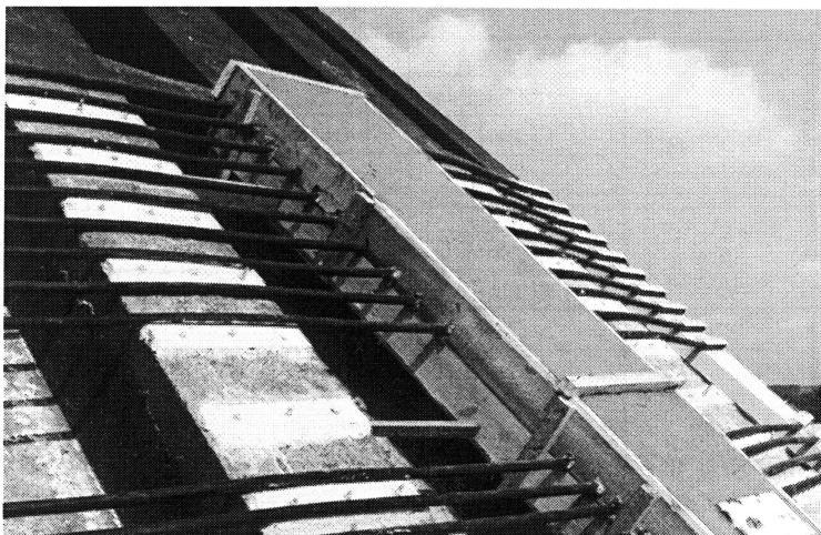
Ryc. 12. Pilaster stalowy po zabetonowaniu
