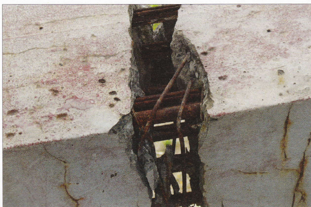
Fot. 3 | Szczegół „A” pasa dolnego żelbetowo-sprężonej kratownicy „a”
