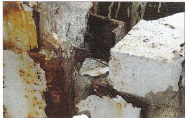
Fot. 5 | Szczegół „A” żelbetowo-sprężonej kratownicy „b”
