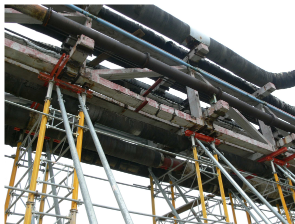
Rys. 3. Tymczasowe podparcie uszkodzonych kratownic
