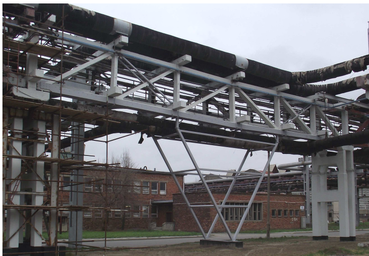
Rys. 13. Widok przęsła po wykonaniu wzmocnienia
