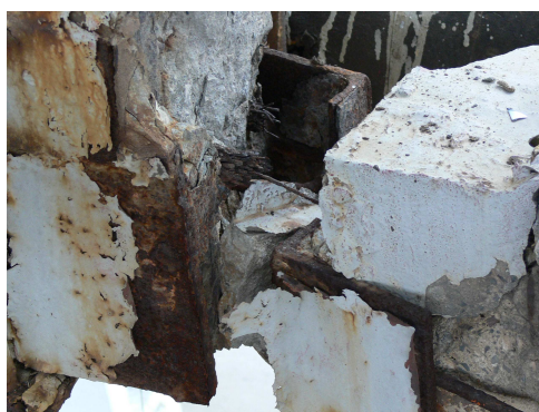
Rys. 7. Szczegół „A” żelbetowo-sprężonej kratownicy „b”
